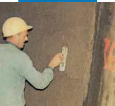
Цементная штукатурка с Planicrete. Строительство автодорожного туннеля в Виль-Мари, Монреаль, Канада
