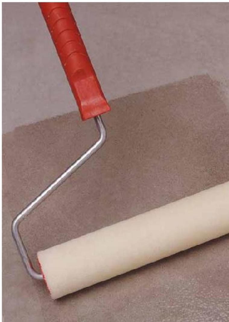
отверждения материал улучшает механические свойства обрабатываемой поверхности, снижает впитываемость и увеличивает стойкость к износу.
