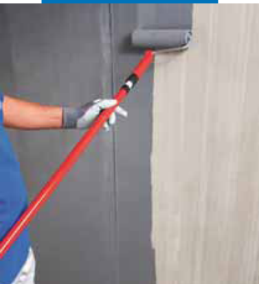
Нанесение Eco Prim Grip валиком на бетонную поверхность
