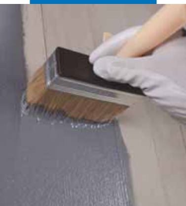
Нанесение Eco Prim Grip кистью на бетонную поверхность
