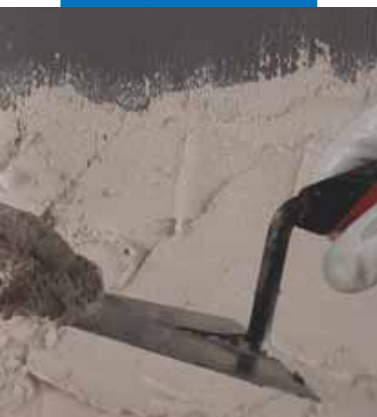
Нанесение штукатурки на Eco Prim Grip
