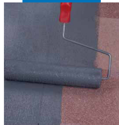
Нанесение Eco Prim Grip валиком на старый мраморный пол
