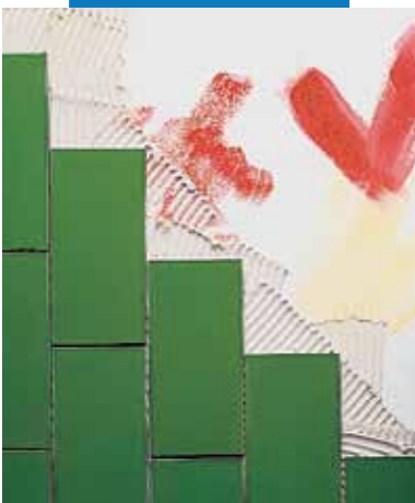
Укладка плитки на окрашенные стены
