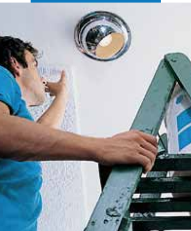
Инсталляция потолка из пенополистирола
