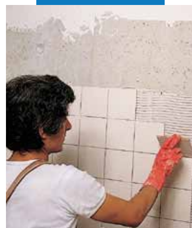
Укладка плитки на железобетон
