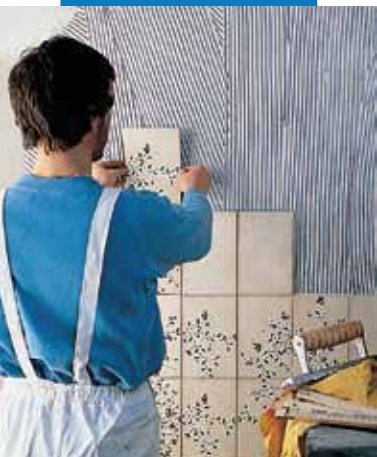
Укладка плитки на обычную штукатурку
