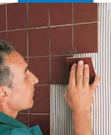
Укладка плитки на гипсовую штукатурку
