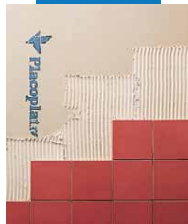
Укладка плитки на гипсокартон
