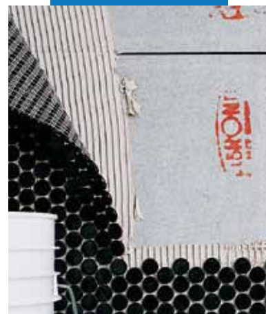
Укладка плитки на фиброцемент
