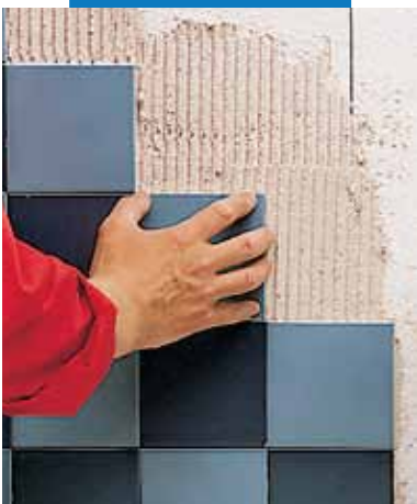
Укладка плитки на пенополистирол
